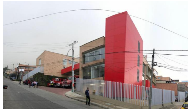
Imagen 29. Fotografía Estación Bellavista
