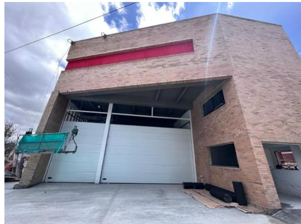
Imagen 30. Estación de Bomberos Marichuela
